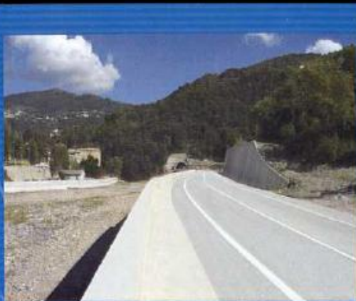
2: Tracciato e imbocco lato Genova galleria della Paglia
