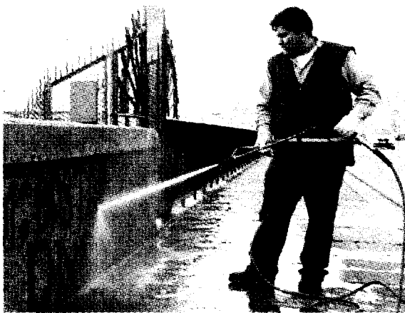
La pulizia delle scritte a spray lungo il percorso
