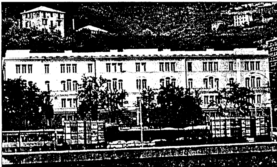
Il palazzo della scuola "Mazzini" è al centro di una contesa urbanistica di grande interesse
