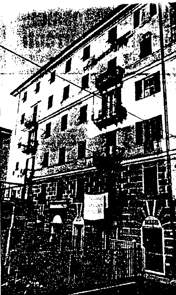
Il civico 13 di passo Ponte Carrega, "condannato" alle alluvioni
